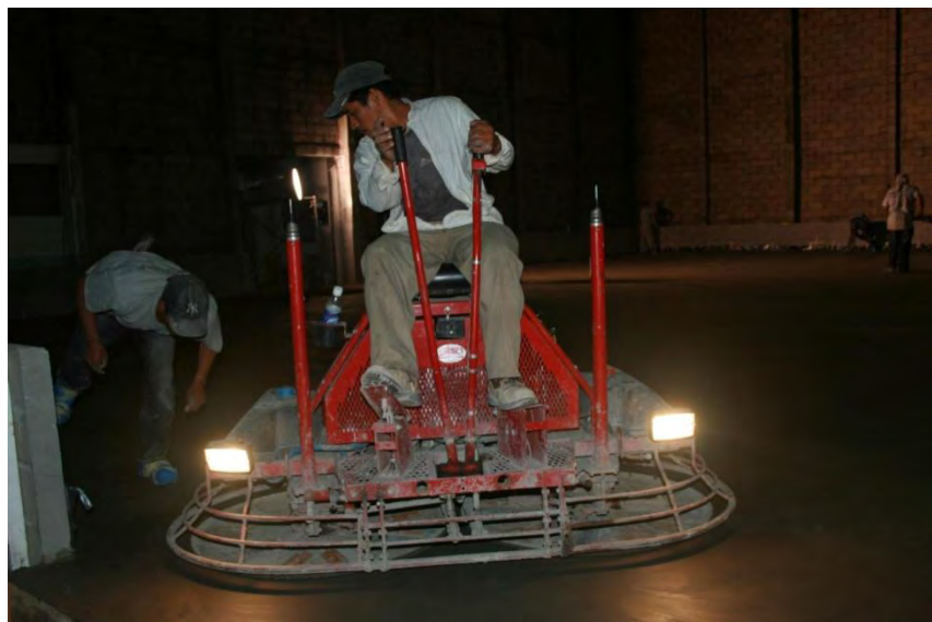
Imagen 4 Allanadora doble en proceso de piso pulido
