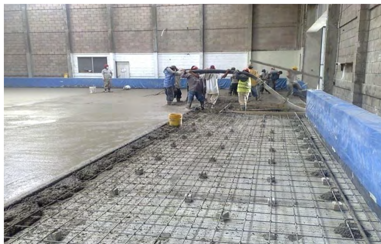
Imagen 2 Proceso de colado utilizando concreto tipo bomba
