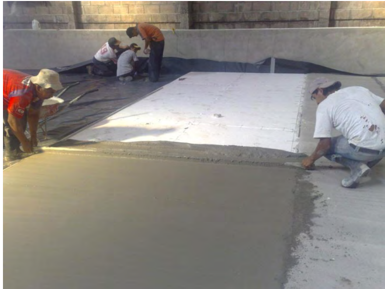
Imagen 3: Aislamiento Térmico con durapax
