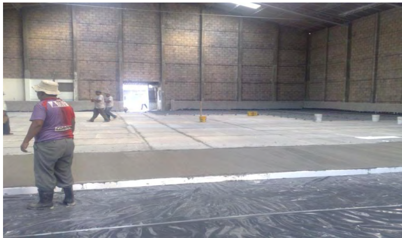
Imagen 1: Ejemplo de aislamiento térmico en bodegas refrigeradas
