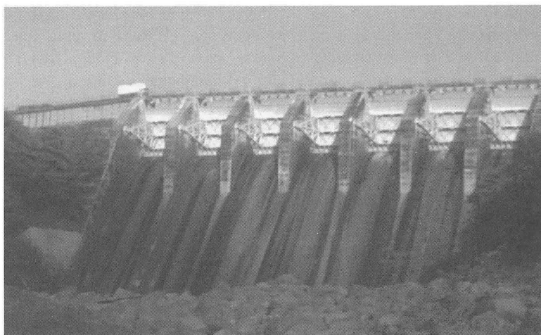
Presa Hidroeléctrica 5 de Noviembre
