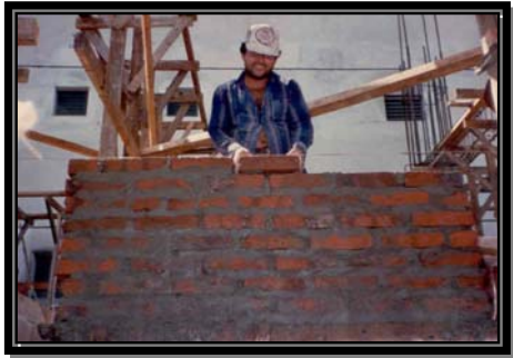
Fig. 5.6.1 Armado de Paredes Ladrillo de Barro
