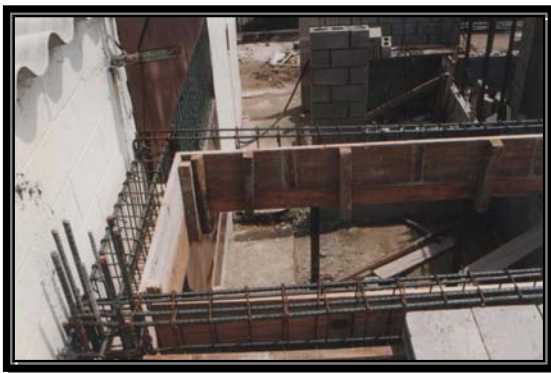
Fig. 5.4.3 Encofrado de Vigas
