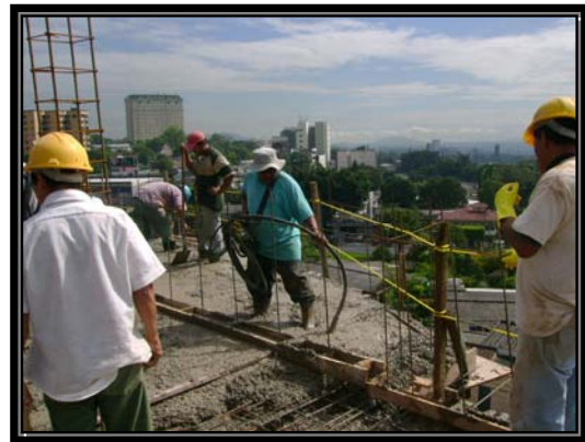
Fig. 5.5.4 Vibrado de Concreto
