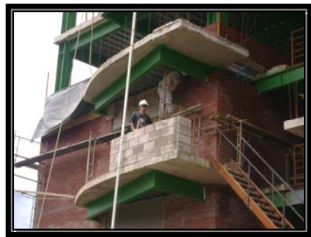
Fig. 5.6.4 Armado de Paredes
