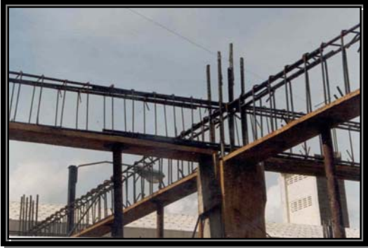
Fig. 5.4.1 Base de Encofrado
