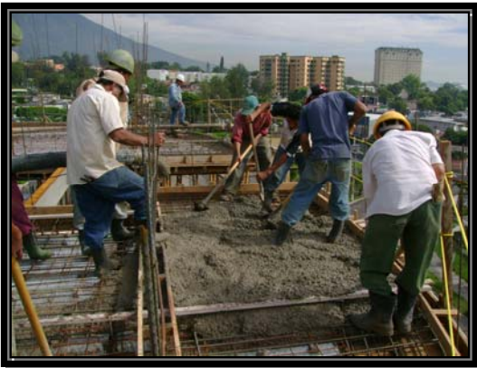
Fig. 5.5.3 Colado de Losa
