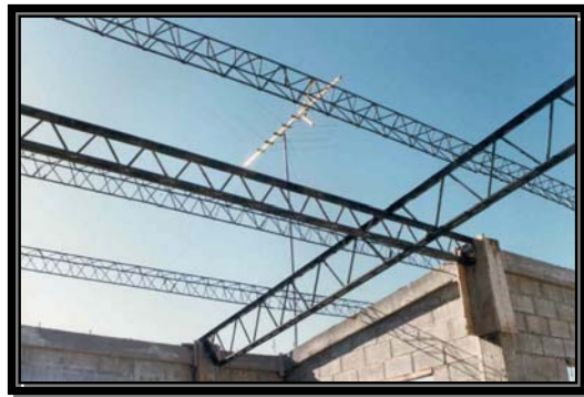
Fig. 5.7.2 Estructura de Techo
