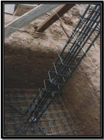
Fig.5.3.1 Armado de Columna
