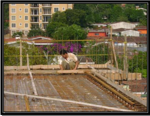
Fig. 5.5.1 Armado de Losa
