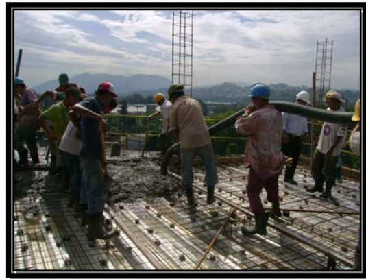
Fig. 5.5.2 Colado de Losa
