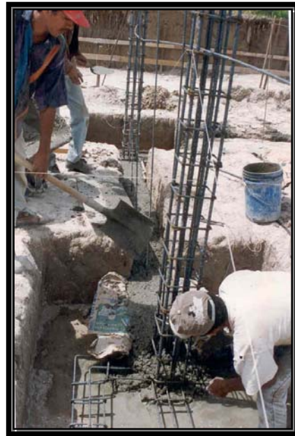
Fig. 5.2.2 Colado de Cimentación
