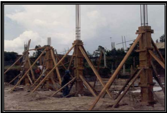
Fig. 5.3.3 Encofrado de Columnas
