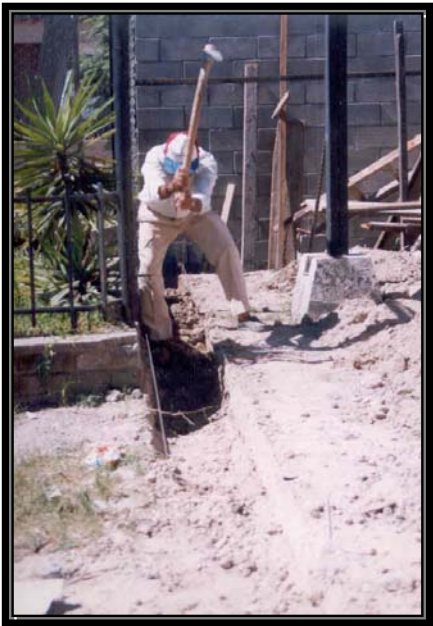
Fig.5.2.1 Excavación de Cimentación
