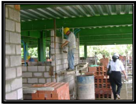
Fig. 5.6.3 Armado de Paredes
