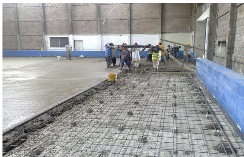
Imagen 2 Proceso de colado utilizando concreto tipo bomba
