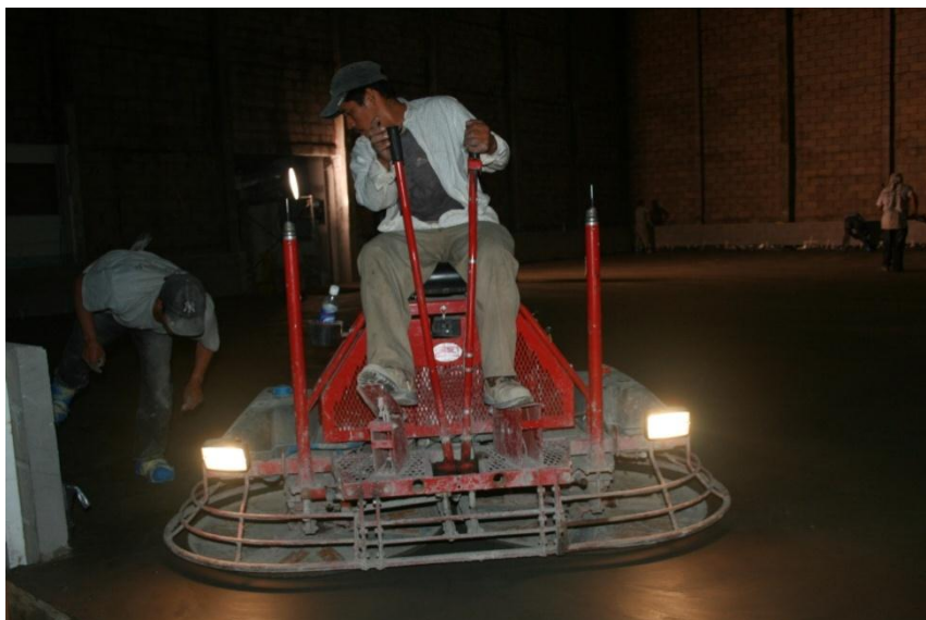
Imagen 4 Allanadora doble en proceso de piso pulido
