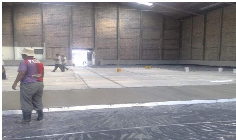
Imagen 1: Ejemplo de aislamiento térmico en bodegas refrigeradas
