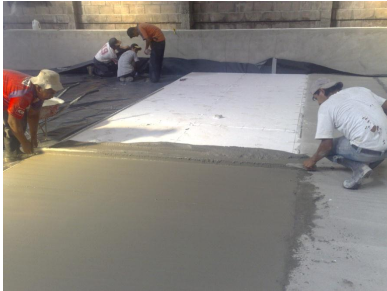
Imagen 3: Aislamiento Térmico con durapax
